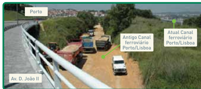
Aterro do canal ferroviário (2011/2012)
