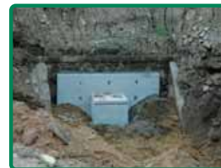
Boca norte do túnel, e respetiva selagem (2012/2013)
